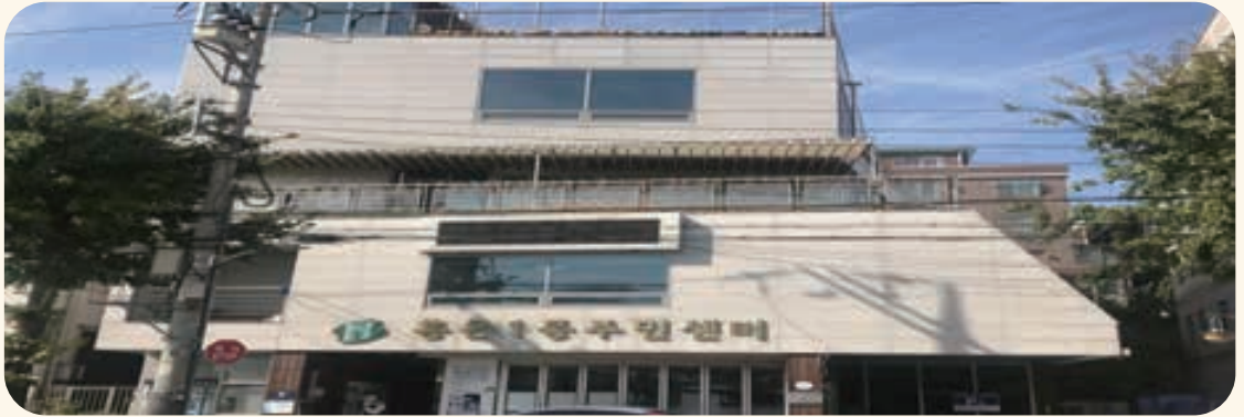
홍은1동 주민센터 전경
