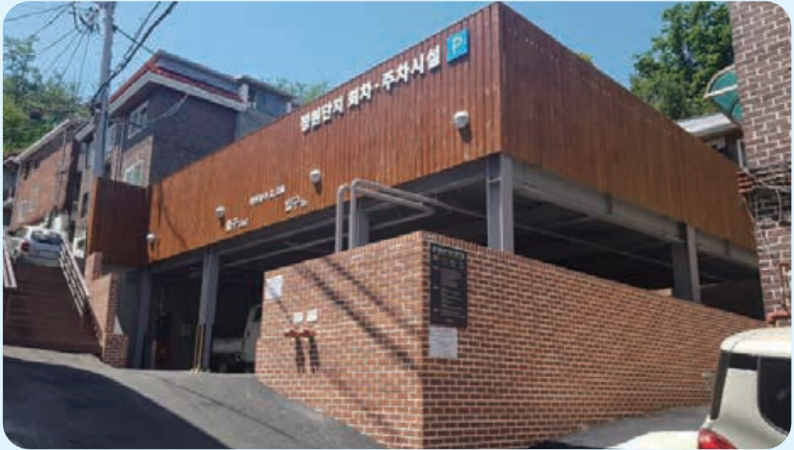
정원단지 주차(회차)시설 외부전경
