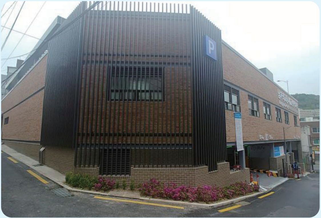
남가좌2동 제2공영주차장 외부전경
