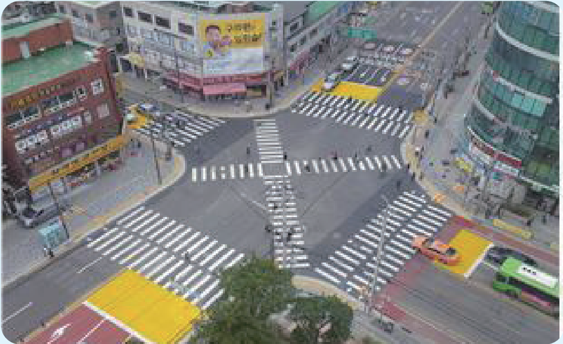
육교 철거 및 대각선 횡단보도 설치
