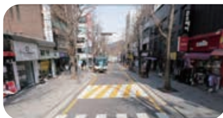
이대 정문앞(공사완료 후)
