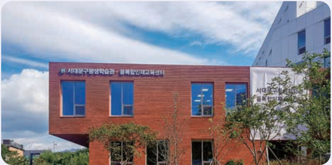
서대문구평생학습관 · 융복합인재교육센터 전경
