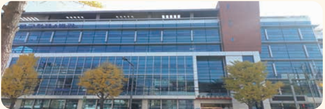
홍은2동 주민센터 전경
